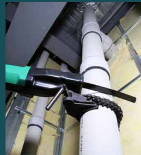
パイプシャフト内の切断
